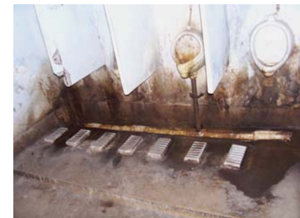
Sanitation block at ITI Durgapur
