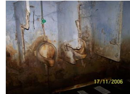
Sanitation block at ITI Durgapur
